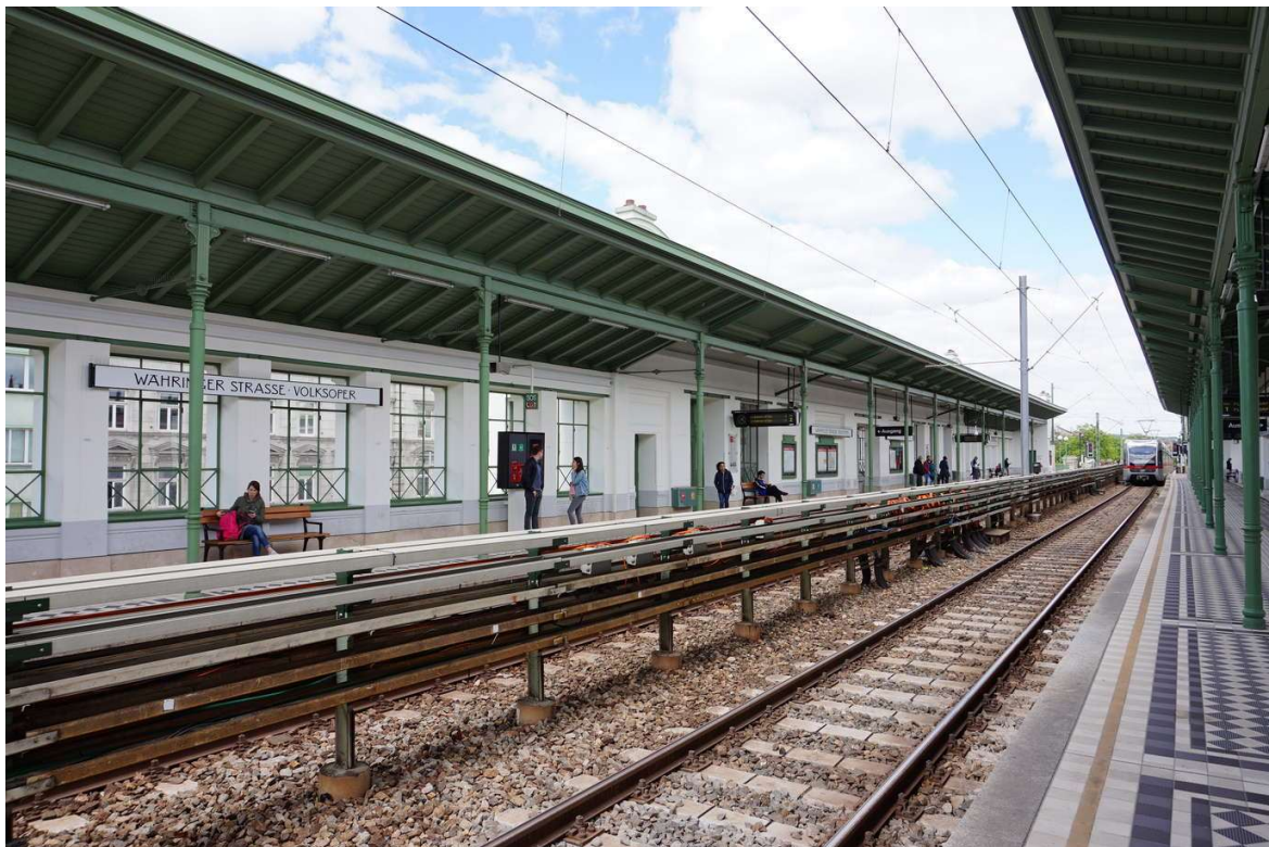
Foto 36 - Piano banchine della stazione ex stadtbahn Währinger strasse - Volksofer, ora linea U6
