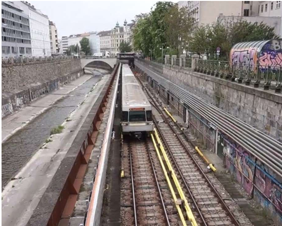
Foto 37 - La linea U4 affiancata al torrente Wienfluss, qui tra Schönbrunn e Meidling Hauptstrasse
