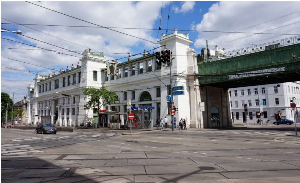
Foto 35 - Vista esterna della stazione Währinger strasse - Volksofer e del ponte sopra Fuchsthaller gasse
