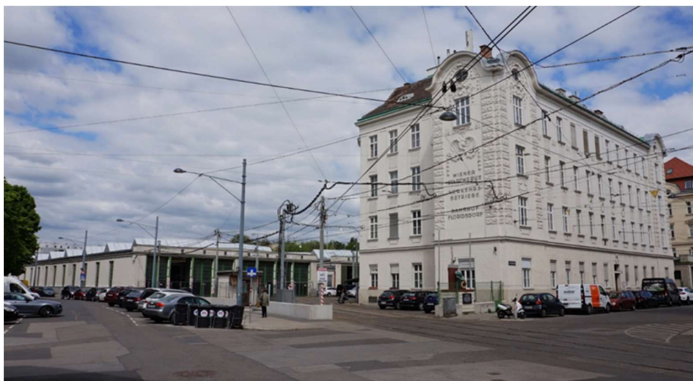
Foto 15 - Deposito tranviario di Florisdorf con annessa palazzina uffici
