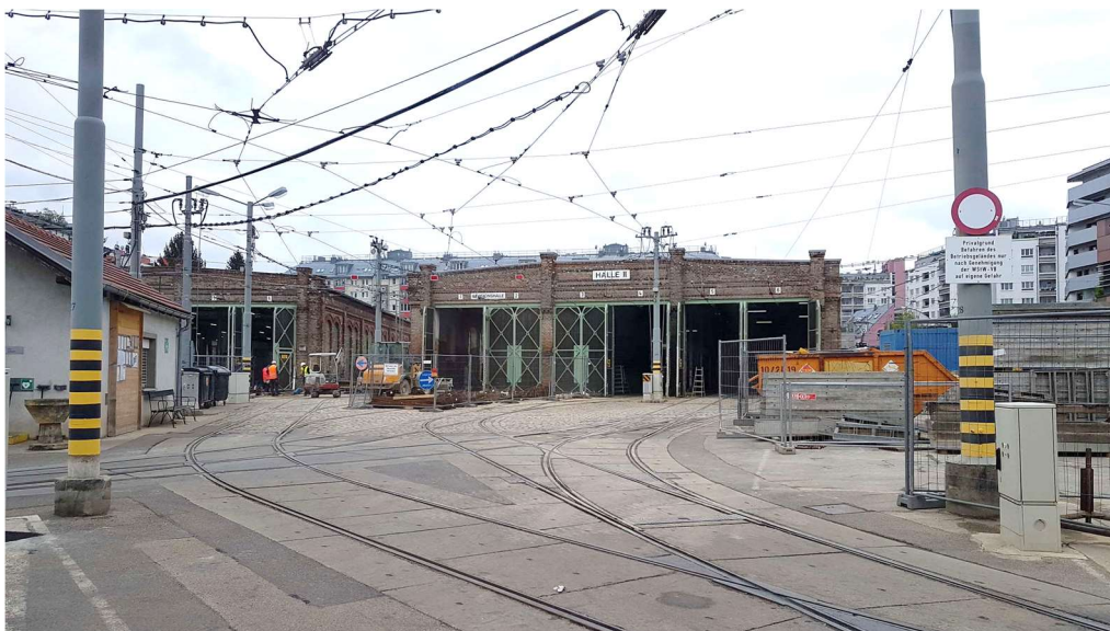
Foto 16 - Lavori di ristrutturazione in corso al deposito tranviario Simmering
