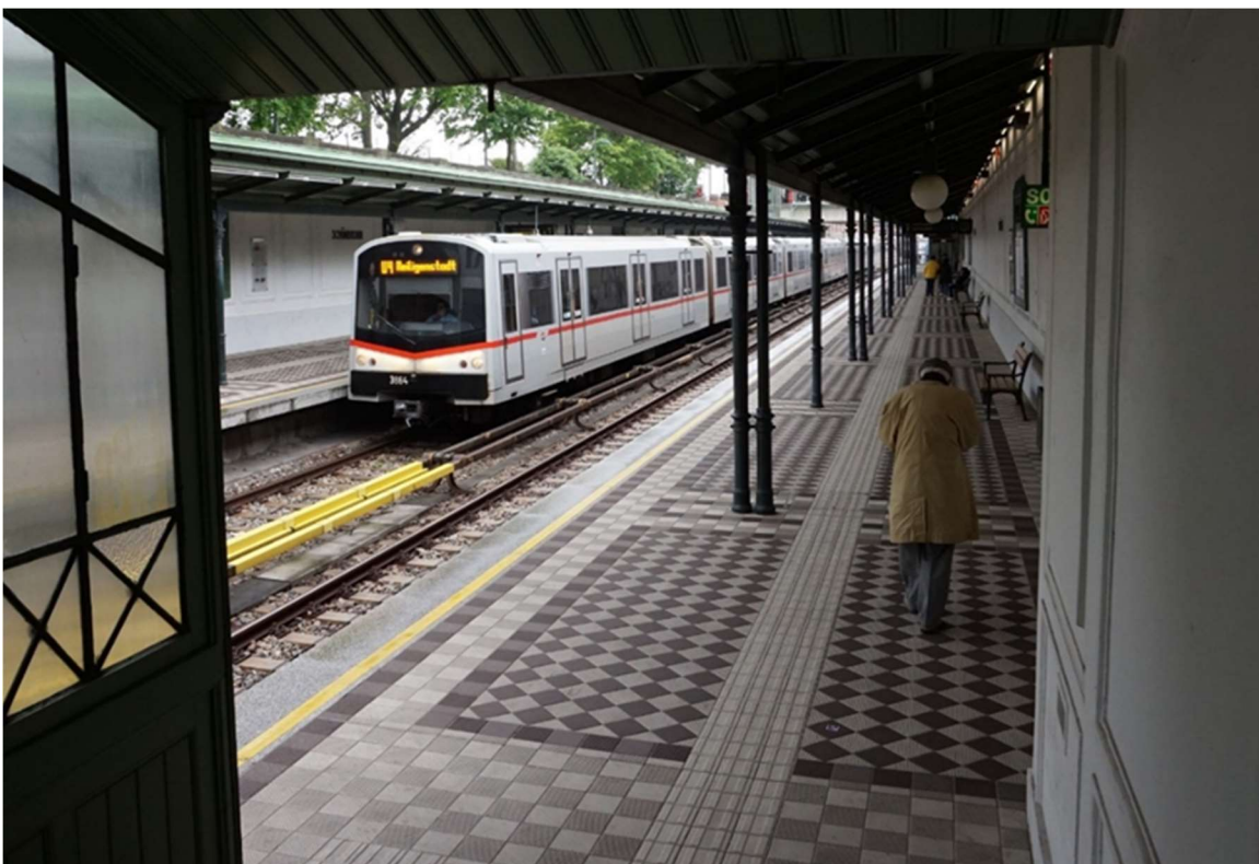
Foto 34 - Banchine della stazione ex stadtbahn Schönbrunn, ora linea U4, con le caratteristiche piastrelle
