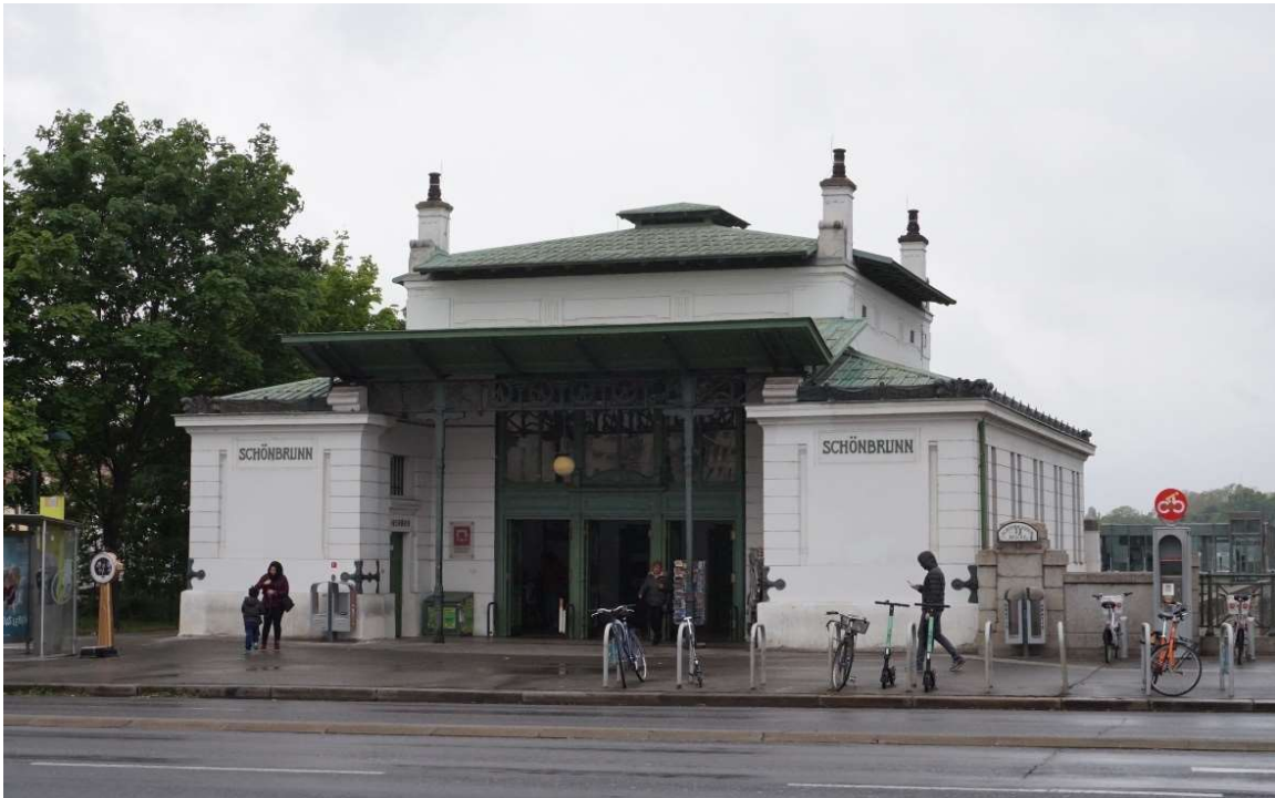
Foto 33 - L' edificio di accesso della stazione ex stadtbahn Schönbrunn, ora linea U4
