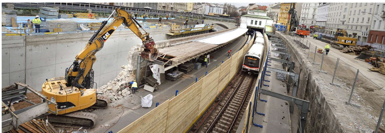
Foto 42 - Vista aerea dei lavori di demolizione banchine in corso alla stazione Pilgramgasse lungo la U4. In questa fase i treni transitano sull'unico binario rimasto. A sinistra il Wienfluss ( fonte: www.wienerlinien.at )
