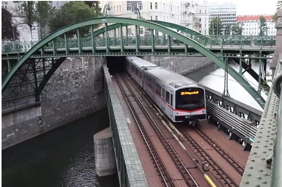
Foto 39 - Il ponte sul Wienfluss tra le stazioni Schwedenplatz e Landstrasse, linea U4
